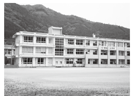
現根雨小学校の校舎を改修
