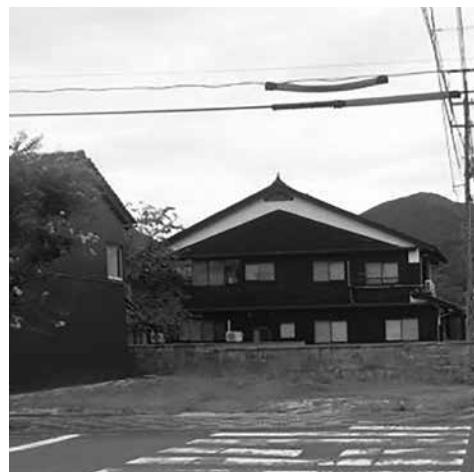
空き家が解体撤去された土地
